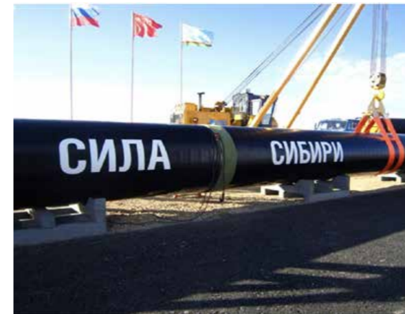
Магистральный газопровод «Сила Сибири»
