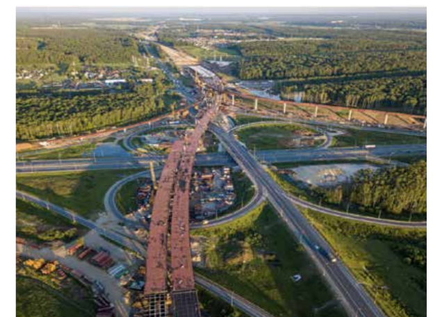
Строительство Центральной кольцевой автомобильной дороги (Московская область)
